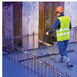
WIERZCH PŁYTY PRZED WARSTWĄ FINALNĄ
